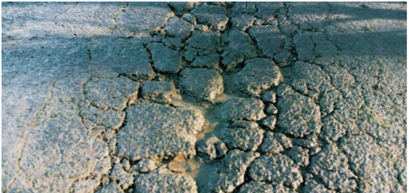
Fig. 1. 7. à État de la route endommagée.
