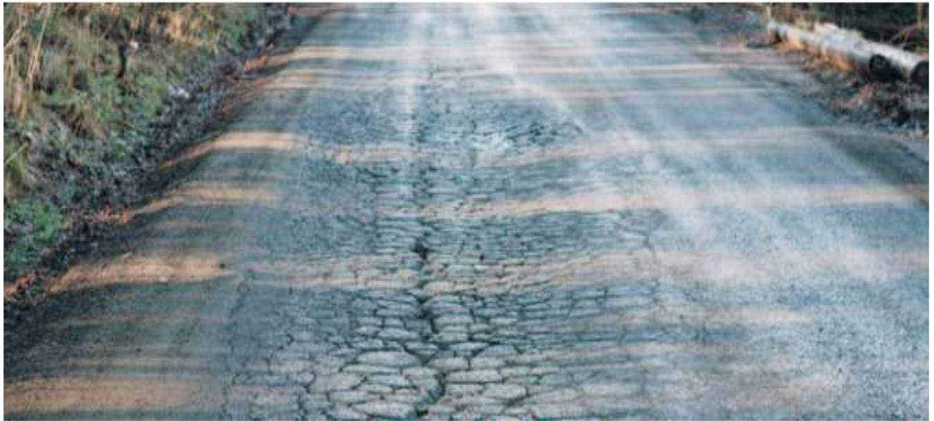
Fig. .1. 7.b De graves détériorations de la couche bitumineuse sont le signe d'une couche de grave bitume instable.
