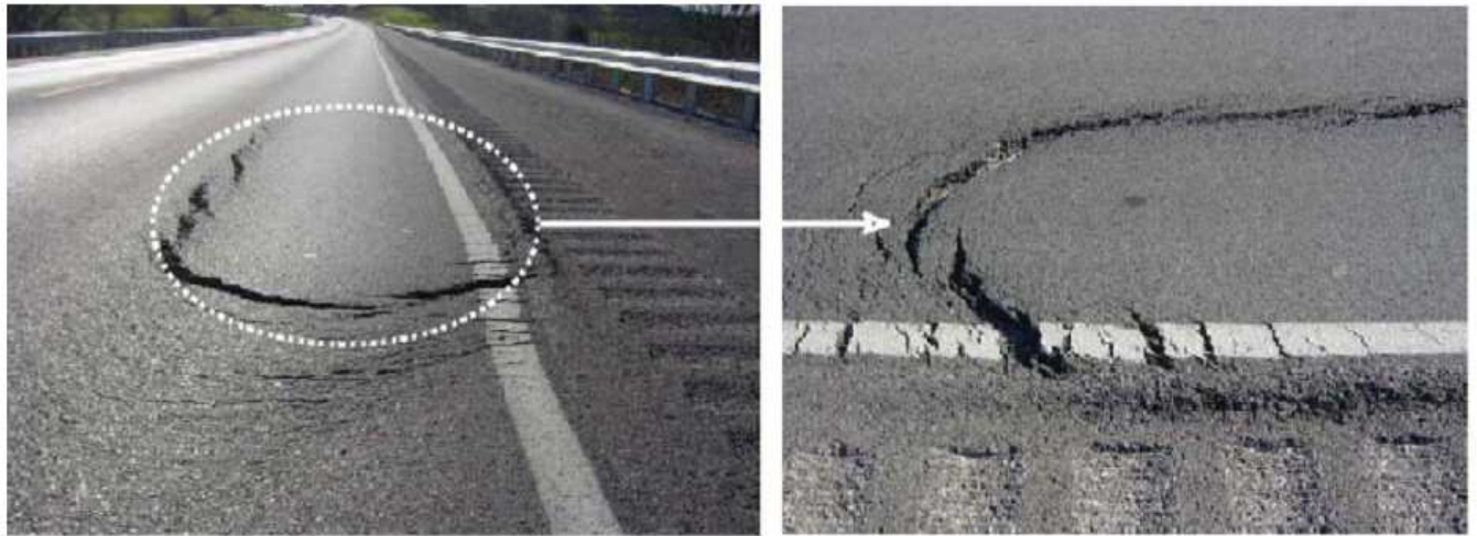
Fig I. 6'. Exemple de dégradation due à un défaut de collage à l'interface [3]
