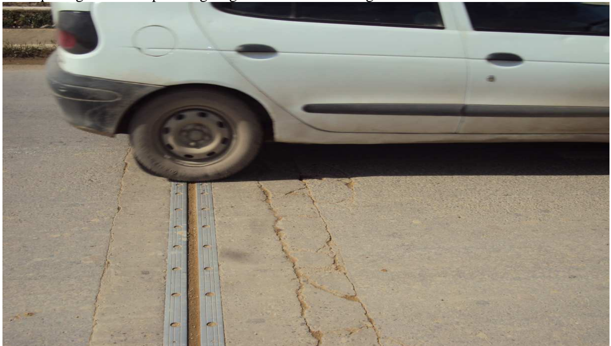
Fig. I. 6 L'interaction véhicule et couche de roulement non régulière (la chaussée de pont de Mina Wilaya de Relizane)
